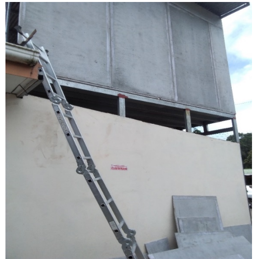
Inspección previa para aprobación de un permiso de construcción
